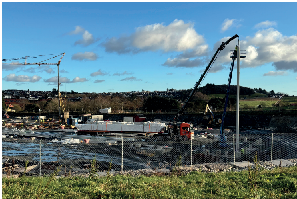
Med stram fremdriftsplan ble en milepæl nådd da den første stålsøylen ble montert på dagen.
