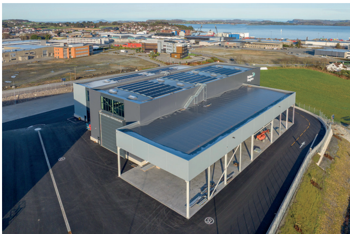
Også utvendige lager er skjermet mot vær og vind.
